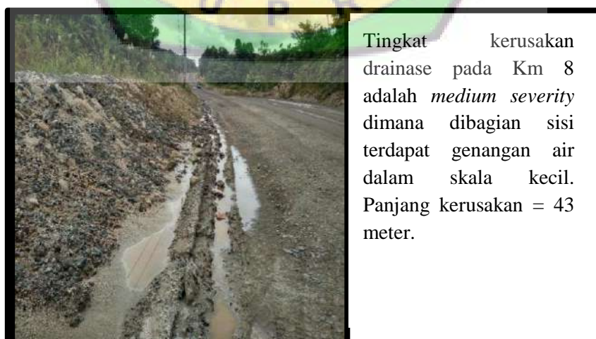
Gambar 4.8 ketidaksempurnaan drainase
