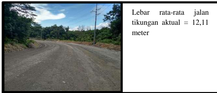
Gambar 4.3 Lebar Jalan Angkut Pada Jalan Tikungan
